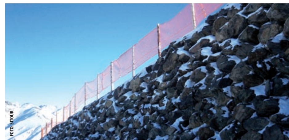
ABSPERRUNGEN. Nicht nur zum Drüberpringen da.
