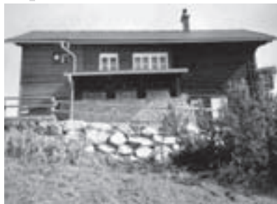
neue Stützmauern der Terrasse
