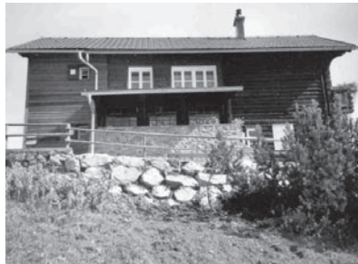
neue Stützmauern der Terrasse
