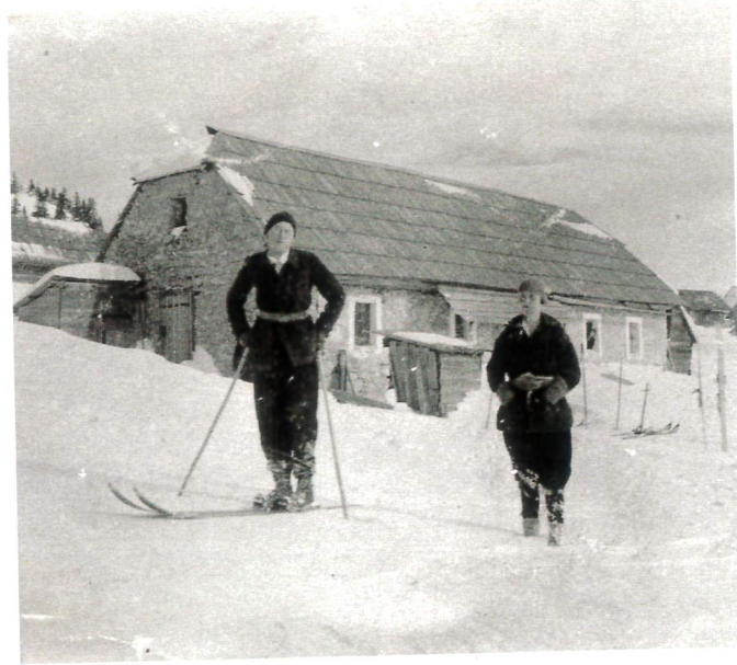
Schließsteinerhaus: 1835 erbaut - mit 2 Schifahrern um 1900
