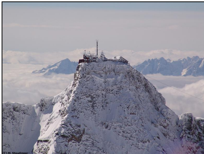
der Hohe Sonnblick mit Zittelhaus u. Observatorium
