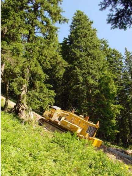
Kanalgrabungen am „Gsollhörn-Steig“
