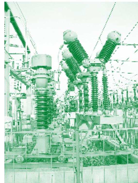
110/20kV Umspannwerk Gleisdorf 110kV Leistungsschalter
